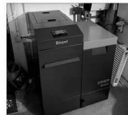
Kombinovaný kotel zapojený v kotelně rodinného domu. Foto archiv/OPOP
